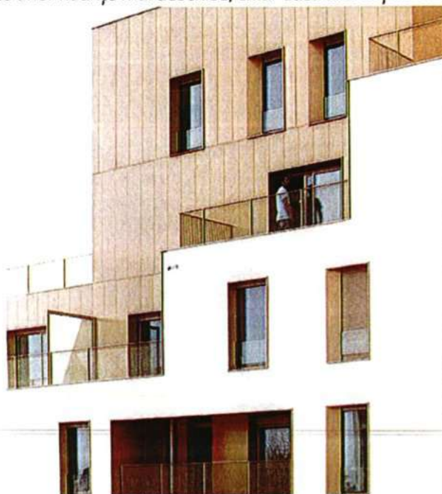
Exemple de tratări ale fațadelor - Accente de culoare. Sursa: TVK Architectes. ZAC du Chaperon Vert, Arcueil
