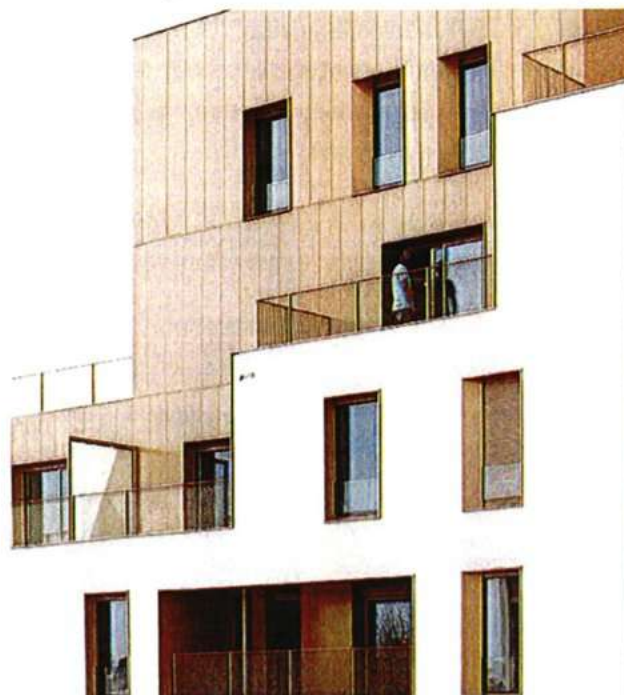
Exemple de tratări ale fațadelor - Accente de culoare. Sursa: TVK Architectes. ZAC du Chaperon Vert, Arcueil
