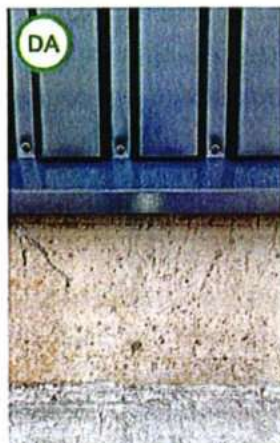
AȘA DA: Soclu realizat din beton, cu finisaj aparent, protejat la partea superioară cu șorț de tablă. Trotuarul de protecție este realizat tot din beton aparent, cu finisaj perlat.
