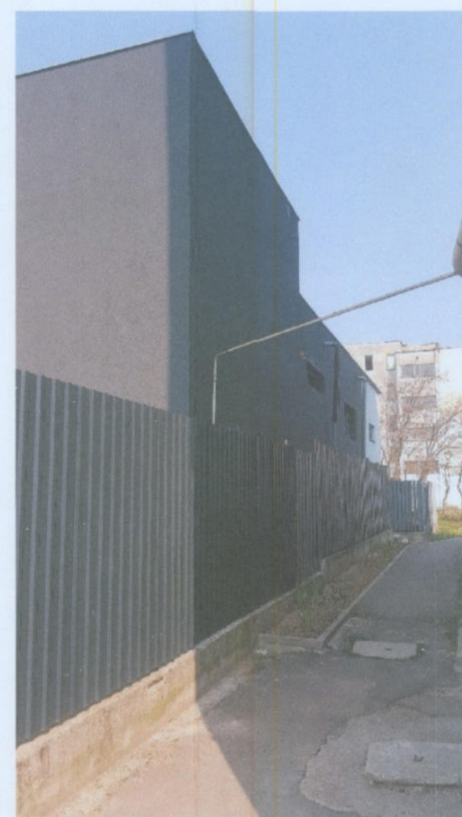
Vedere EST - existent
