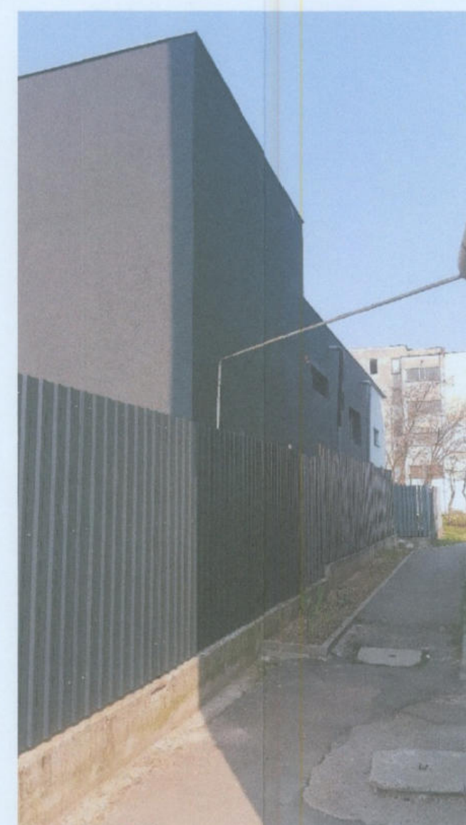
Vedere EST - existent
