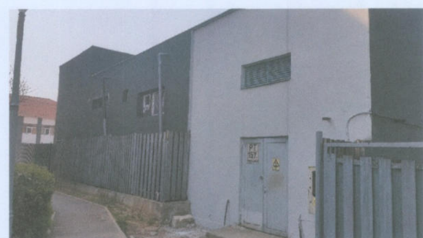
Vedere EST - post trafo existent
