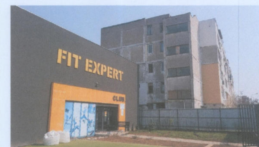
Vedere SUD - existent
