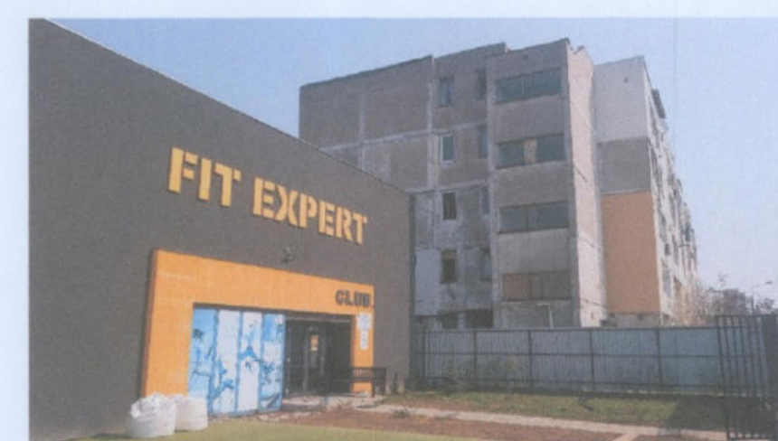
Vedere SUD - existent
