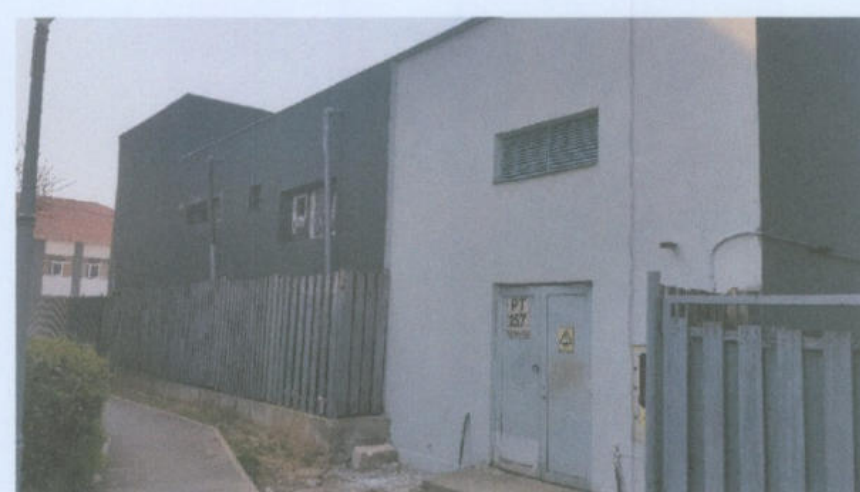
Vedere EST - post trafo existent
