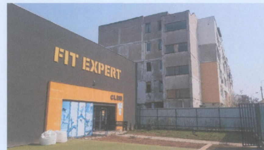
Vedere SUD - existent
