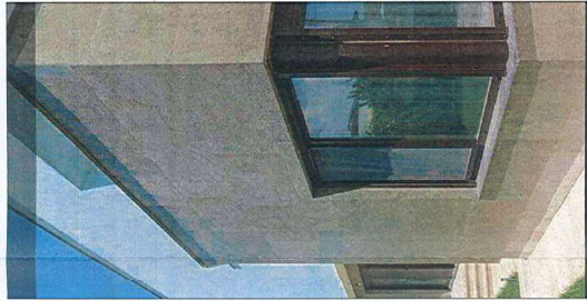
exemplificare - placaj ardezite fâșuită pentru pereți (montată fără rosturi) - tencuială compactă cu granulație mică
