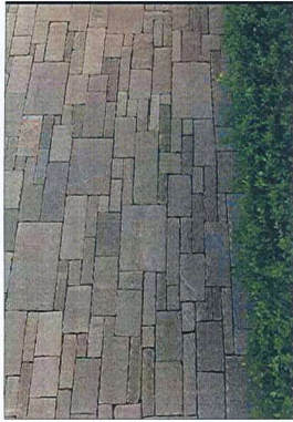
exemplificare placaj ardezite pentru socluri
