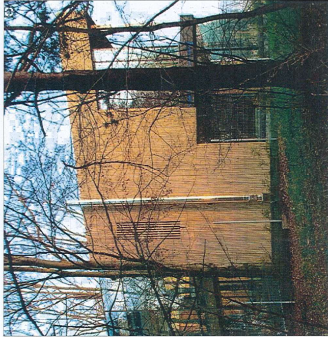
exemplificare - placaj ardezite fâșuită pentru pereți (montată fără rosturi) - tencuială compactă cu granulație mică
