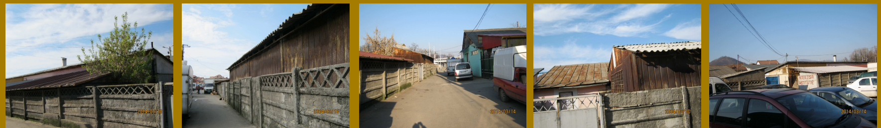
Anexe propuse pt.demolare in prima etapa, eliberarea amplasamentului, largirea zonei drumului, deschiderea pentru circulatie a strazii infundate
