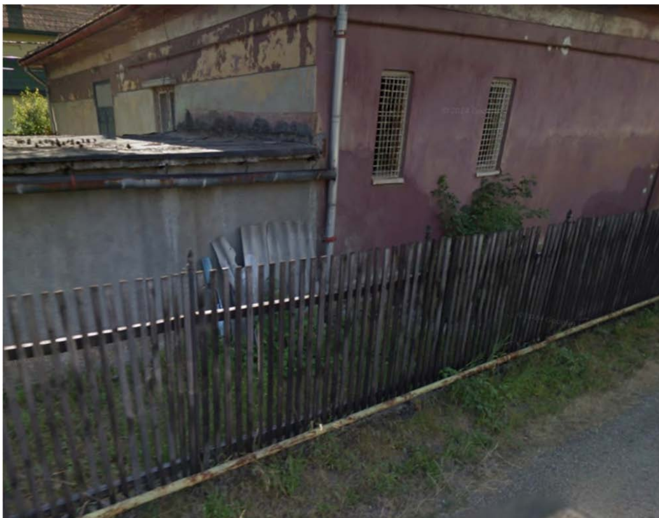
Strada Atleților, amplasarea conductei de gaze naturale de-a lungul împrejuririlor proprietăților.
