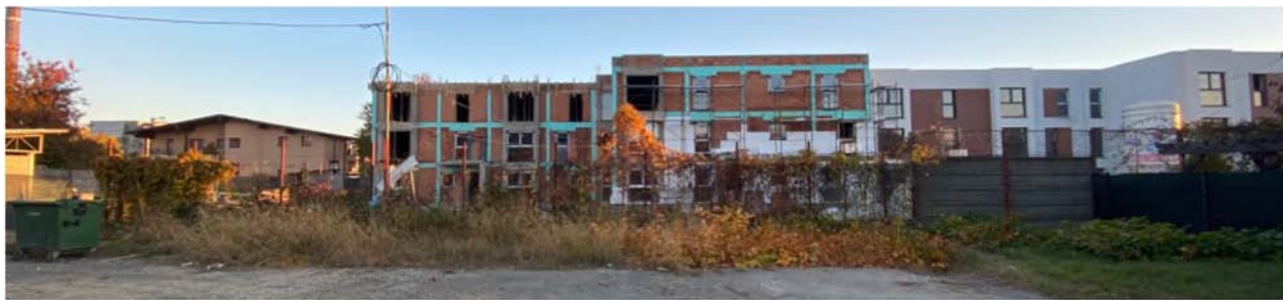
Cele 4 blocuri în construcție pe terenul cu nr cadastral 128328, octombrie 2021
