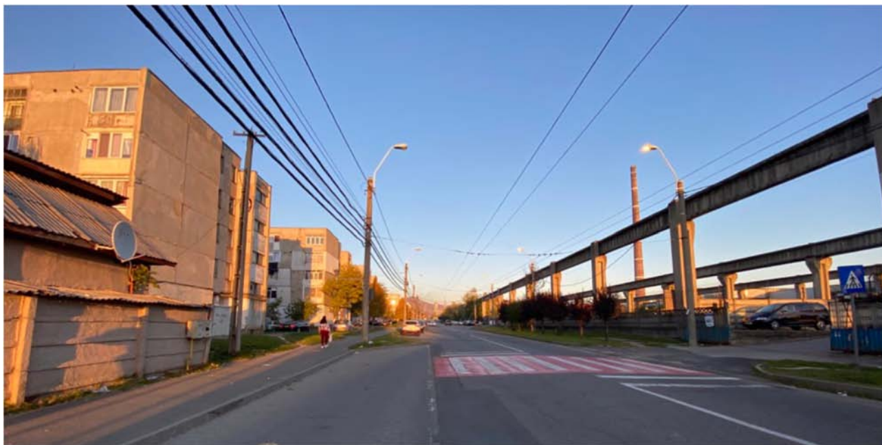
Strada Luminișului, vedere către est
