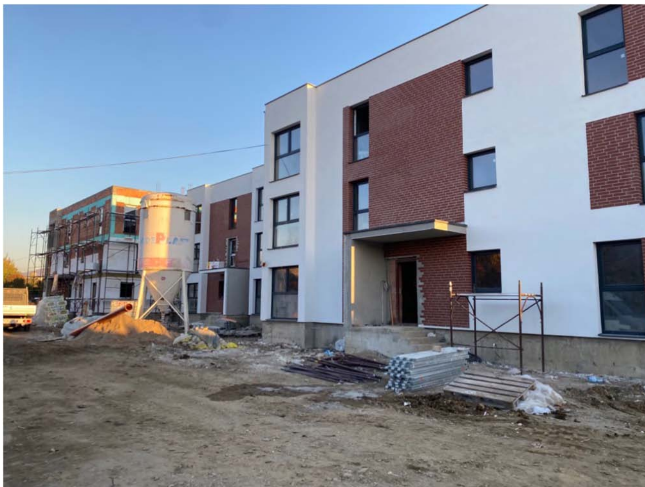
Cele 4 blocuri P+2 edificate/în curs de edificare pe lot (octombrie 2021)
