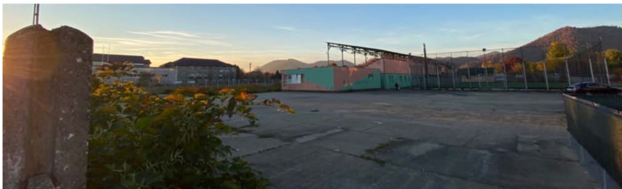
Tribuna și magazia adiacentă terenului de fotbal.
