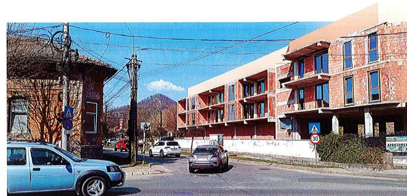
VEDERE DINSPRE STRADA VICTORIEI - PROPUȘ - la intersecția cu strada Valea Roșie
