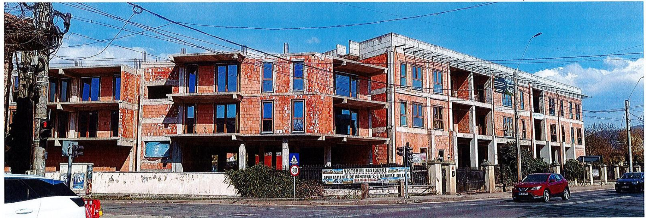
VEDERE DINSPRE STRADA VICTORIEI - EXISTENT - perspectivă de colț, se observă faptul că cele două corpuri ajung la același nivel
