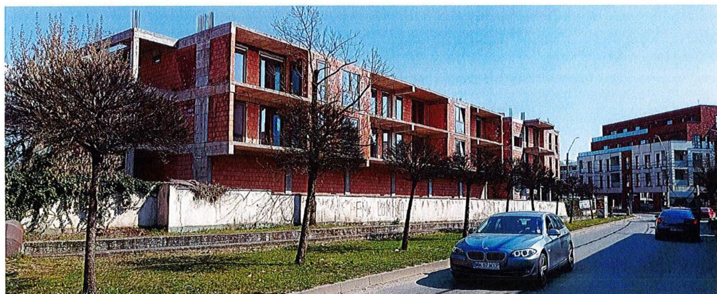
VEDERE DINSPRE STRADA VALEA ROSIE - EXISTENT
