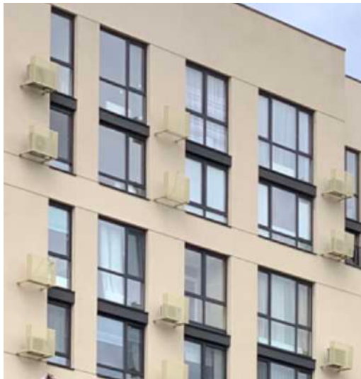
Exemplu de mascare a aparatelor de aer condiționat amplasate pe fațadă cu tablă perforată sursă: https://archimatika.com/en/projects/fayna-town
