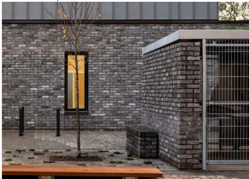
Exemplu de tratarea spațiilor destinate colectării deșeurilor într-o manieră similară funcțiunii principale. Sursă: Marmalade Lane, Cambridge
