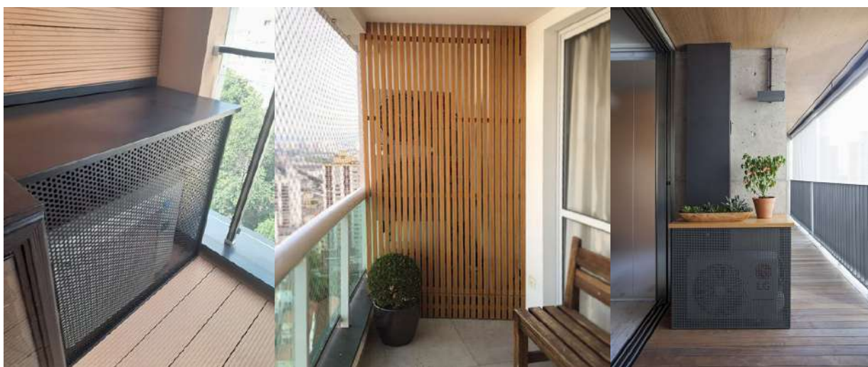
Exemplu de mascare a aparatelor de aer condiționat amplasate pe balcon. a. Tablă perforată b. Riflaj lemn
