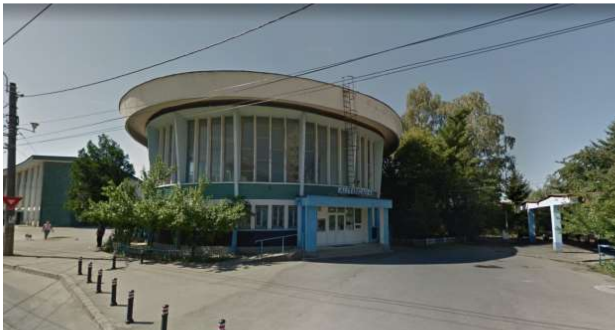
Figură 59 - Corp principal Autogara Baia Mare
